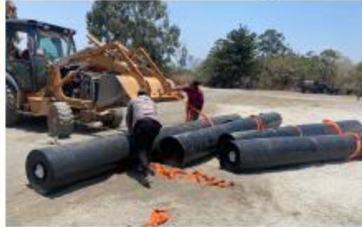
Descarga de rollos de plástico para geomembranas en la localidad de San Miguel.
